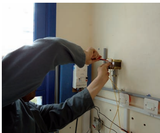
Jeune détenu en formation électricité / bâtiment
