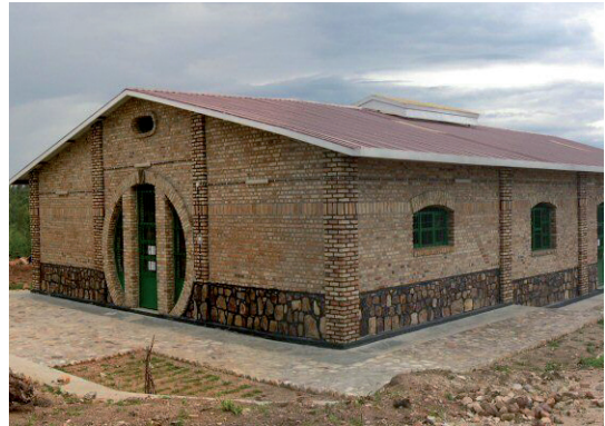
CFJ de Nyanza en cours de réhabilitation
