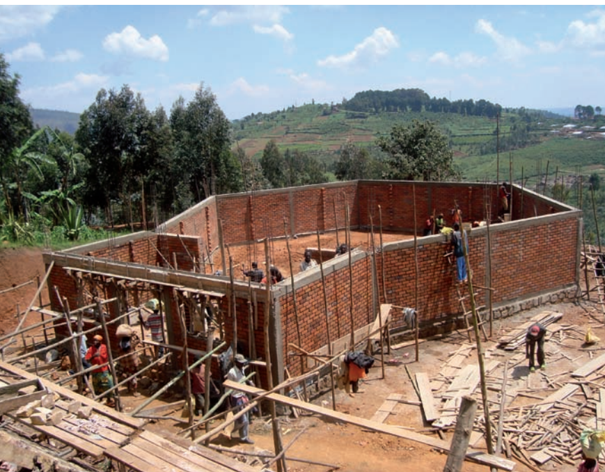
CEM pilote en chantier de Muramvya
