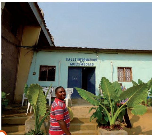
Un des premiers niveaux d'appui du programme concerne la réhabilitation des infrastructures et la mise à disposition de matériel.
