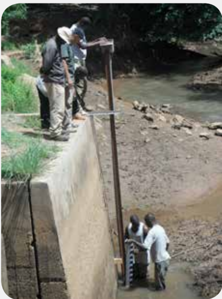
Installation de la station hydrologique afin de quantifier les flux liquides et solides et d'optimiser la gestion du système d'irrigation.
