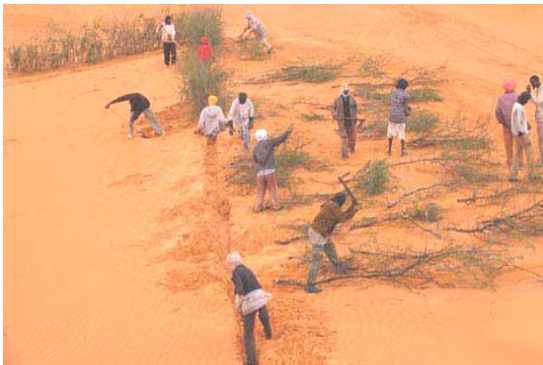
Photo 18 : Creusage de tranchée
