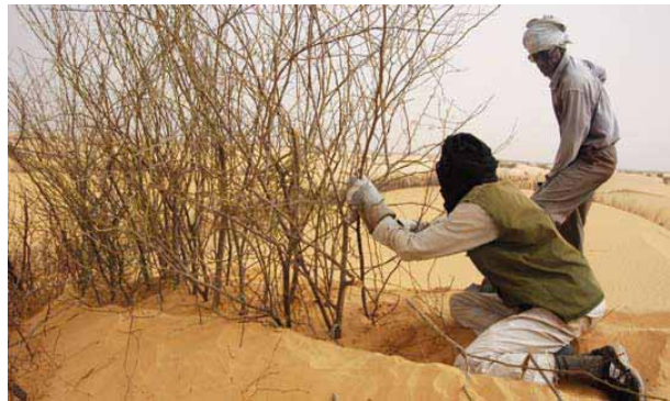
Photo 19 : Pose de clayonnage
