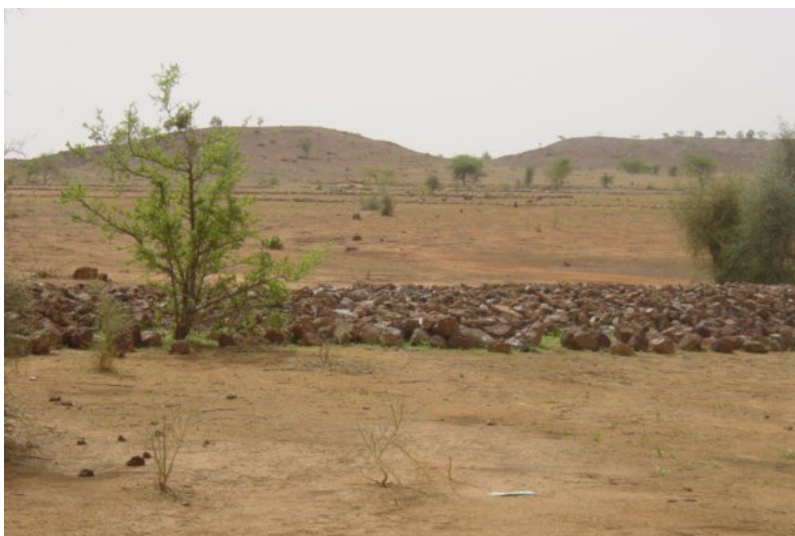
Photo 43 : Succession de digues filtrantes (PGRNG)
