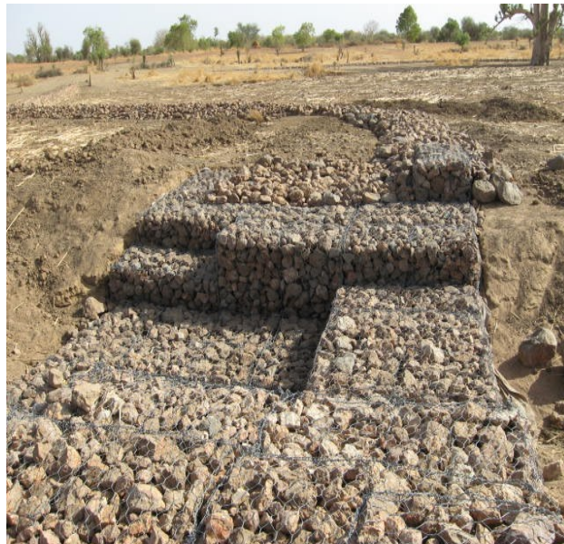
Photo 44 : Digue filtrante mixte dans le village de Waret Lekehel : structure en gabions suivi d'une digue filtrante prolongé d'un cordon pierreux (Source : PGRNG)
