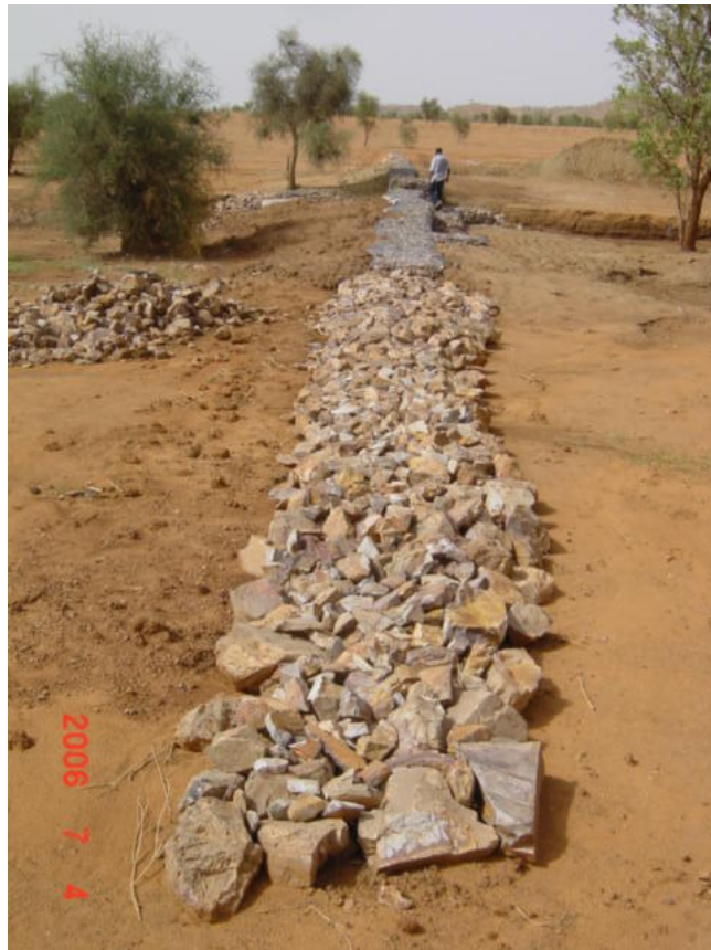
Photo 45 : Digue filtrante mixte dans le village de Hassi Chegar : structure en gabions au lit de l'oued et d'une digue filtrante entre les deux rives (Source : PGRNG)
