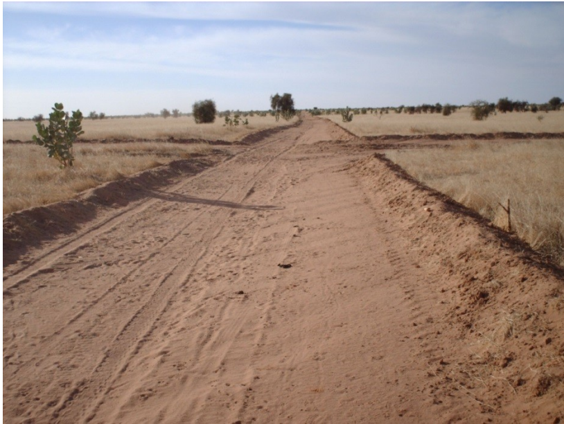
Photo 58 : Aspect d'un pare-feu
