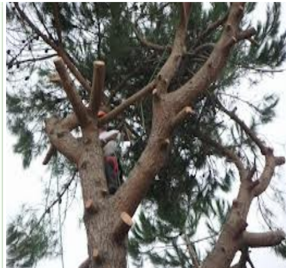
Photo 51 : Opération d'émondage en cours
