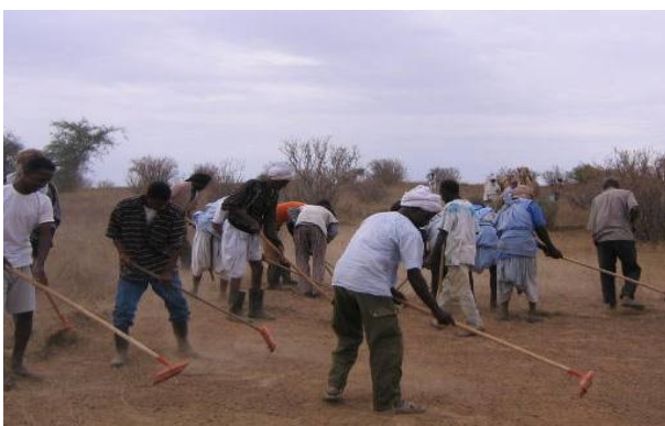
Photo 56 : Pare-feu réalisé manuellement
