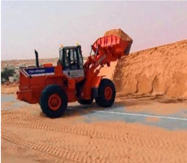
Photo 8 : Désensablement mécanique de la Route de l'Espoir : axe Nouakchott-Boutilimit.
