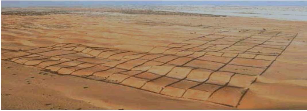
Photo 14 : Clayonnage croisé (ceinture verte de Nouakchott)
