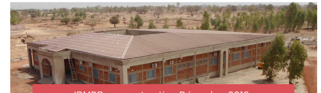
IBMPR en construction Décembre 2018
