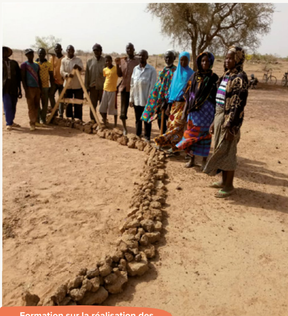
Formation sur la réalisation des cordons pierreux assurée par un formateur endogène - avril 2019
